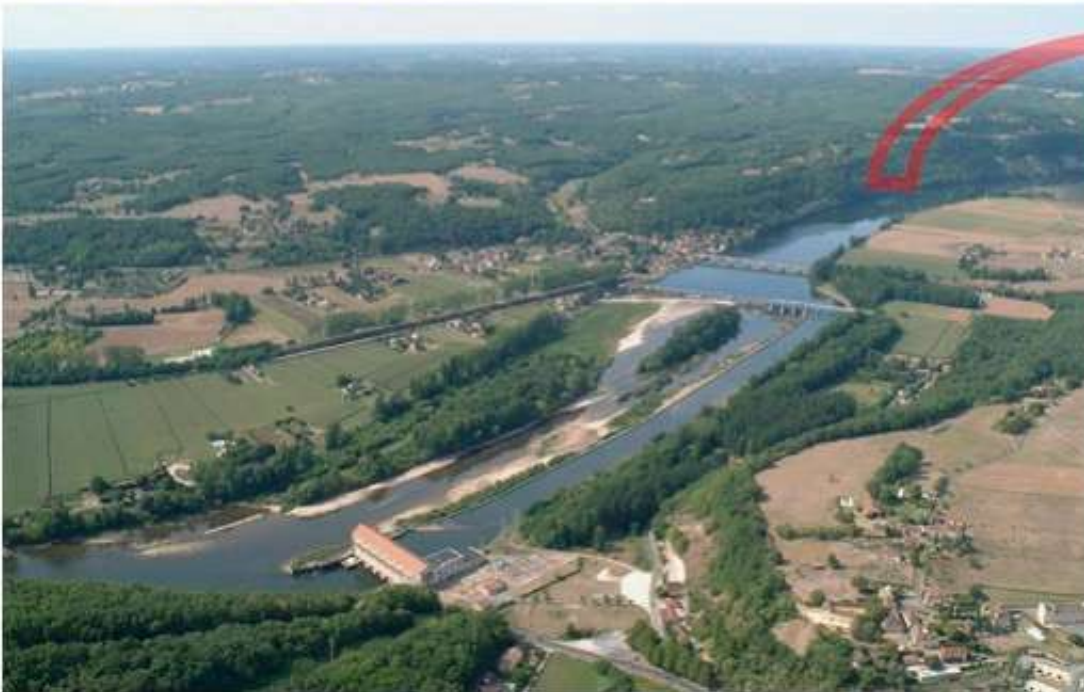
Retenue et barrage de Mauzac
