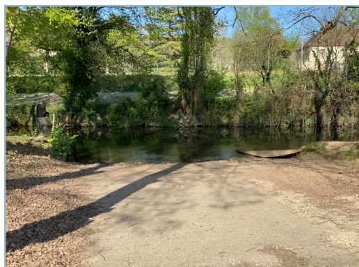
Cale de Trémolat, sur la Dordogne (travaux)
