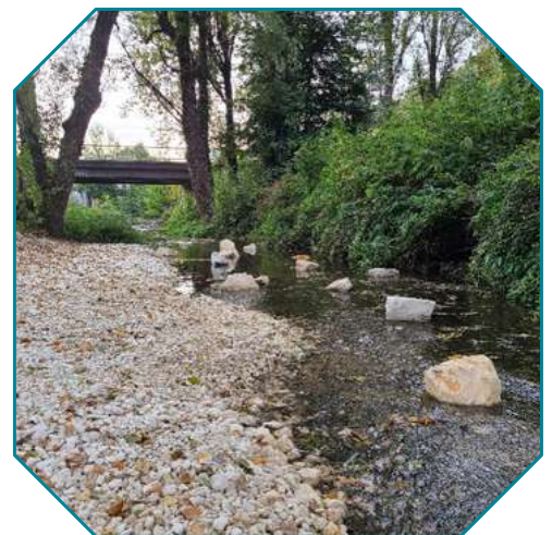
Etat après travaux
